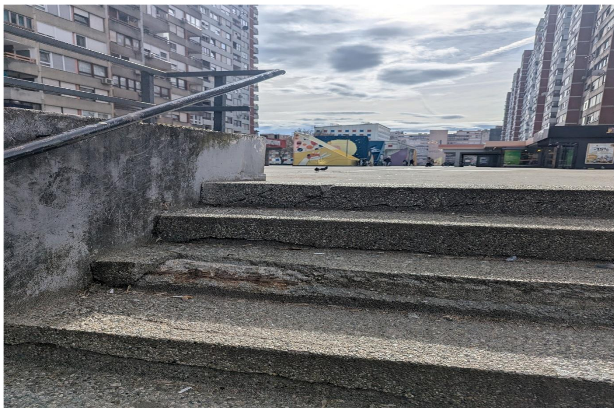
Prilog 3. Fotodokumentacija - oštećenje stubišta
