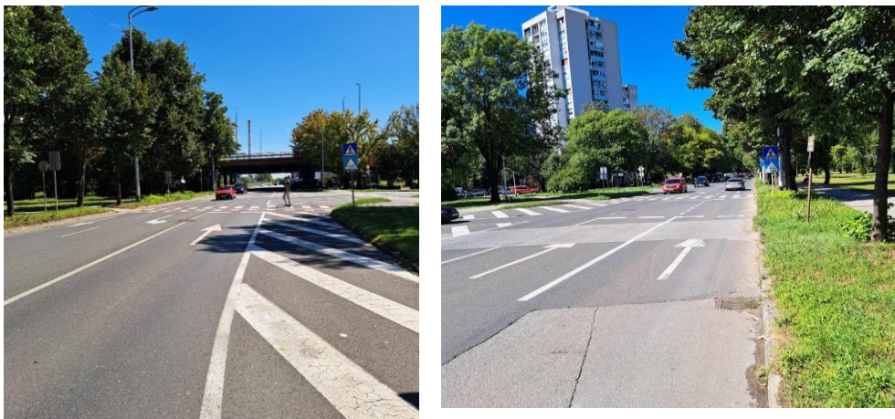
Fotografije postojeće signalizacije i pješačkog prijelaza
