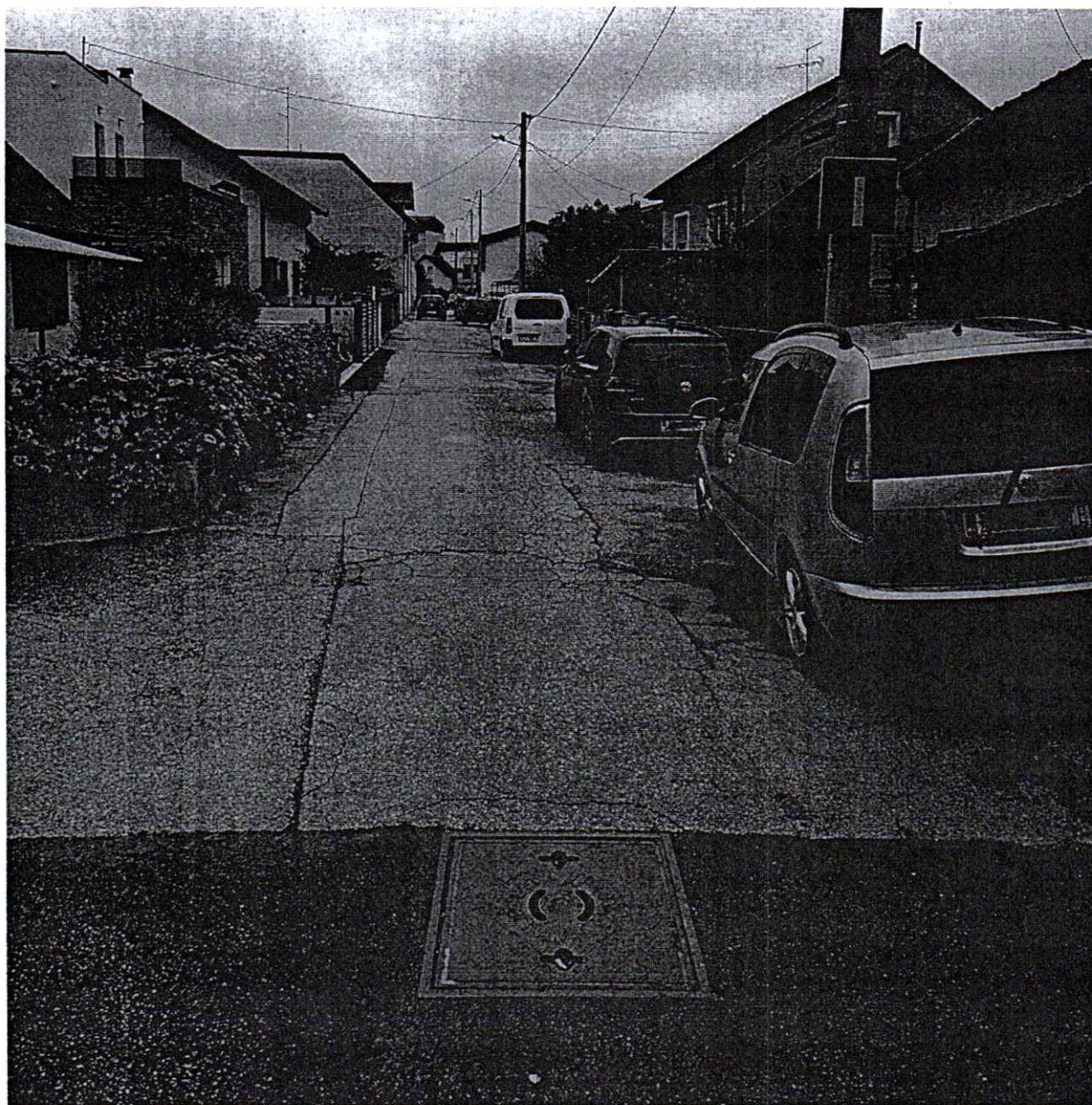
Jelaspoljska ulica - asfaltiranje i kanalice
