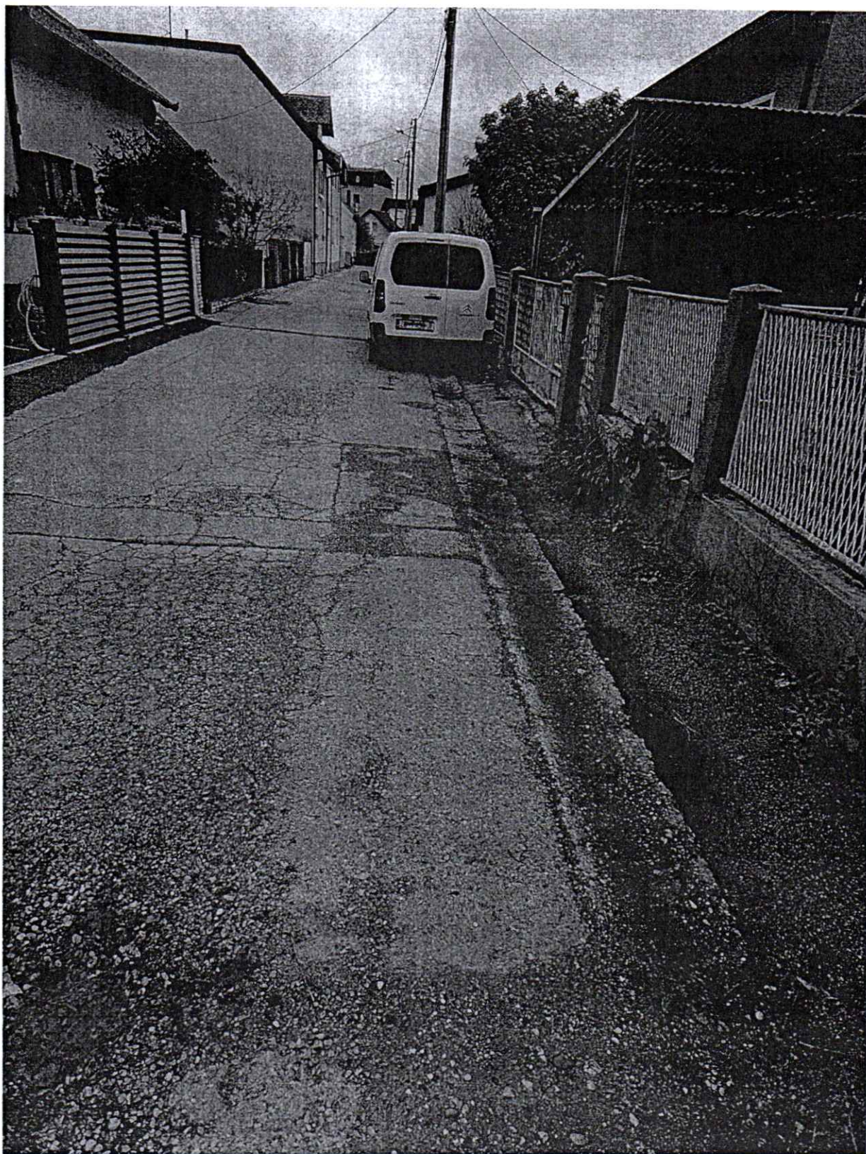
Jelaspoljska ulica - asfaltiranje i kanalice
