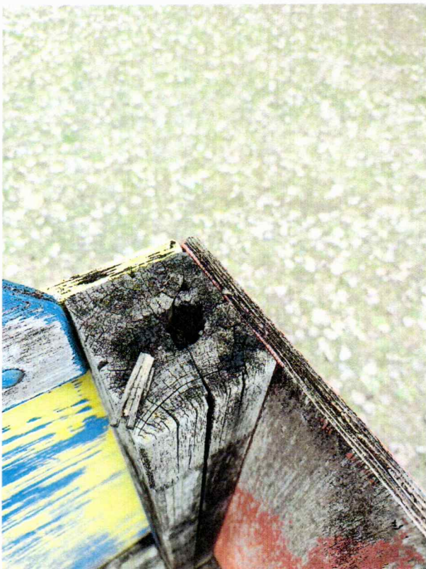
Foto 05 – nosivi stupovi višenamjenske sprave su dotrajali i nedostaju zaštitne kape na vrhovima stupova
