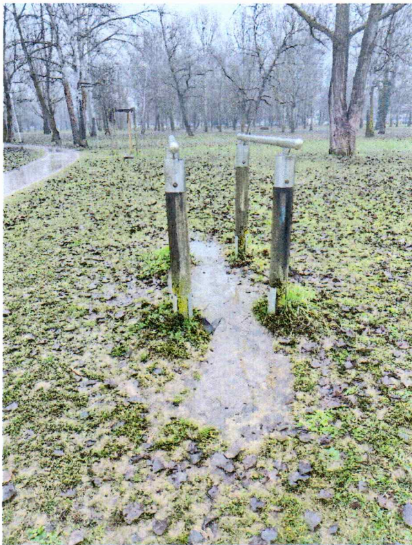
Foto 15 – nosivi stupovi su truli, a nakon kiše se stvara blato ispod sprave
