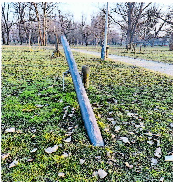
Foto 07 – nedostaje zaštitni stupić oko metalnog dijela koji drži klackalicu za balans
