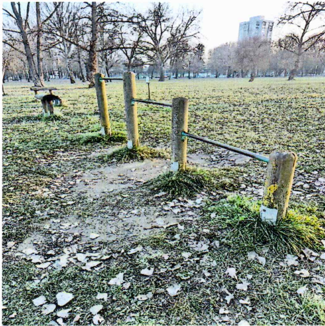
Foto 08 – nosivi stupovi su dotrajali i strunuli, svako dinamičko vježbanje može predstavljati opasnost
