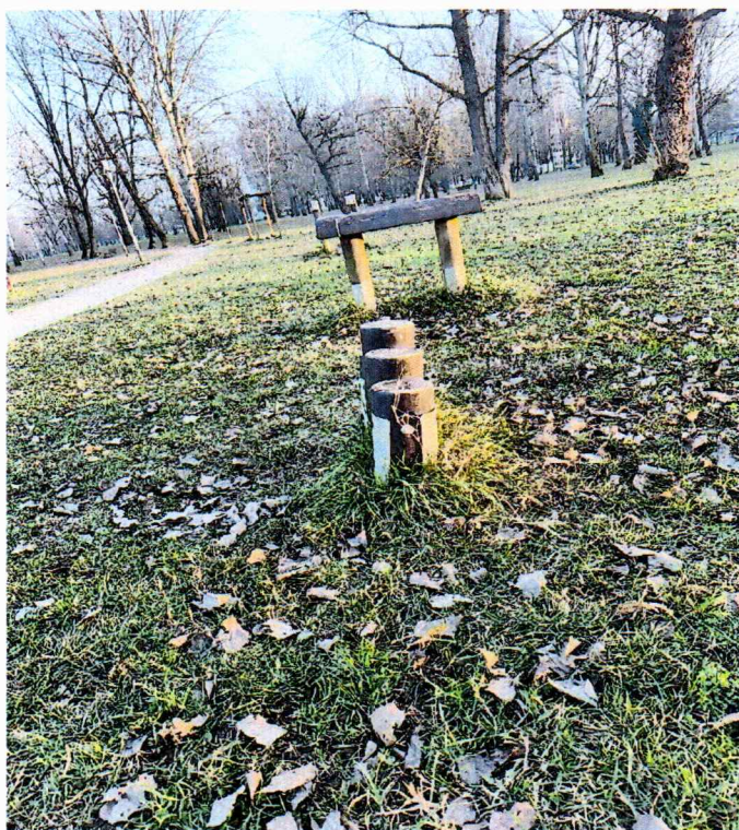
Foto 10 – stupići su zabijeni su pod kutem, a ne vertikalno, vježbanje je otežano
