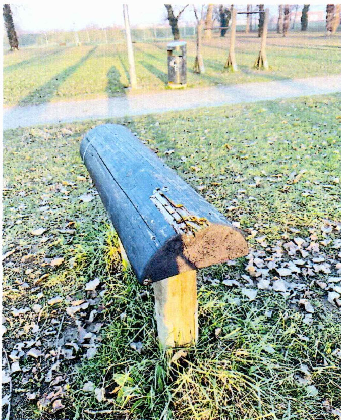
Foto 11 – sprava ima oštećenja
