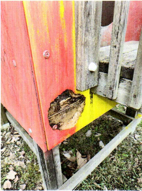
Foto 03 – truli i oštećeni dio višenamjenske sprave
