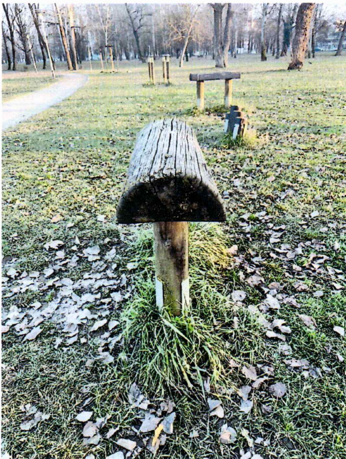
Foto 09 – sprava je strunula i potrebna je obnova
