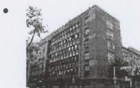
Uglovnica, Svačićev trg, Zagreb (1953.)
