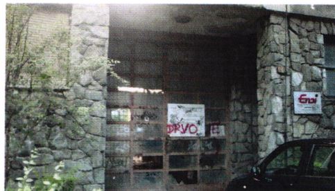
FOTODOKUMENTACIJA - POSTOJEĆE STANJE POSLOVNO-STAMBENA GRAĐEVINA "Nada Dimić" / Branimirova-Erdodyjeva
