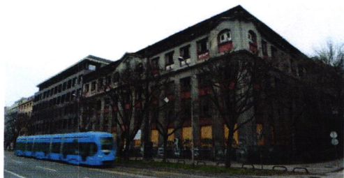
FOTODOKUMENTACIJA - POSTOJEĆE STANJE POSLOVNO-STAMBENA GRAĐEVINA "Nada Dimić" / Branimirova-Erdodyjeva
