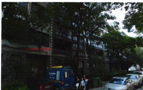
IZVOD IZ ARHIVSKE DOKUMENTACIJE / fotodokumentacija POSLOVNO-STAMBENA GRAĐEVINA "Nada Dimić" / Branimirova-Erdodjeva
