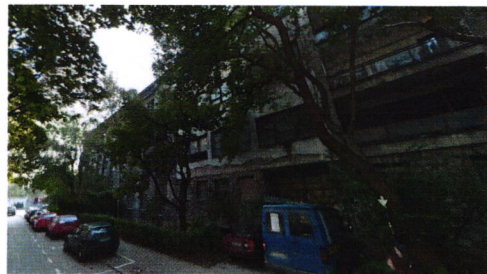
FOTODOKUMENTACIJA - POSTOJEĆE STANJE POSLOVNO-STAMBENA GRAĐEVINA "Nada Dimić" / Branimirova-Erdodyjeva
