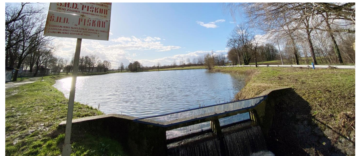
slika 4. pogled iz Golobreške ulice na branu i ribnjak
