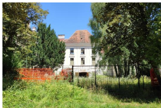
slika 18. južno pročelje, fotografirano 8. srpnja 2020.
