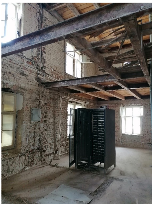
Obnova zgrade u ulici R. Austrije 18
