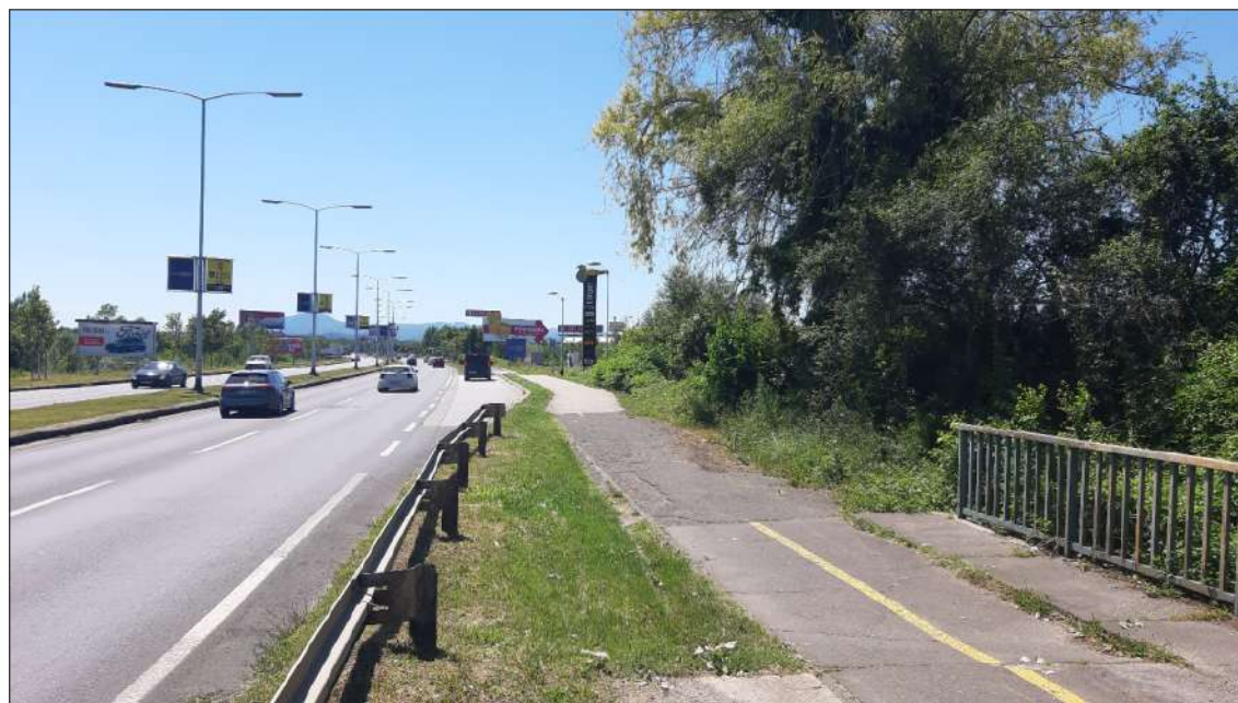
POSTOJEĆI ODVOJAK SA LJUBLJANSKE AVENIJE PREMA SERVISNOJ CESTI I BENZINSKOJ CRPKI (SMJER ZAPAD)
